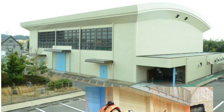
◎多目的実習棟
