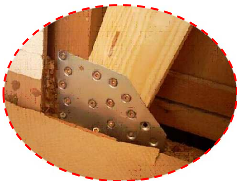
耐震改修の例（筋交い金物補強）
