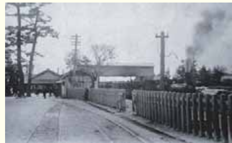
明治末期頃の岡崎駅 (駅開業は明治21年)
