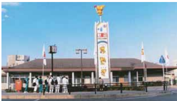
旧駅舎（平成6年頃）
