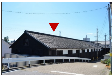
図2-5-18 ②新甲子蔵 (昭和14年(1939)建築)
