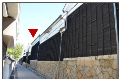
図2-5-22 ⑦乾蔵 (明治7年(1874)建築)
