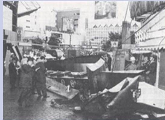
台風で落下した時の様子
