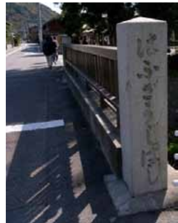
法蔵寺橋高欄の修景整備
