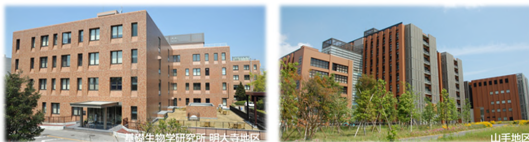
▲大学共同利用機関法人自然科学研究機構 岡崎共通研究施設
