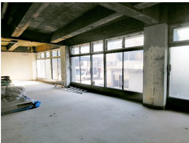
内部（工事中）①
