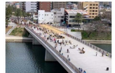
桜城橋橋上広場・橋詰広場の整備・運営
