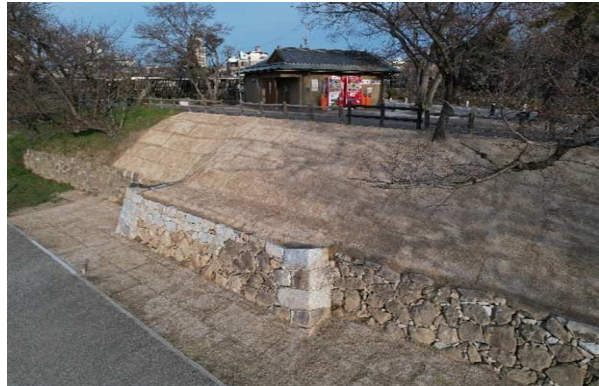
菅生川端石垣西柵形整備
