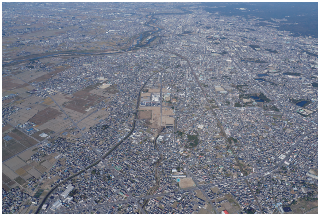
写真3 岡崎駅南土地区画整理事業区域周辺
