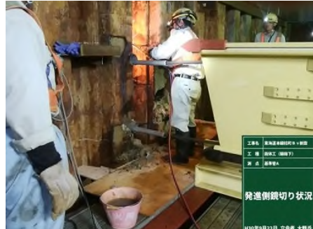
鏡切り（線路西側立坑）
