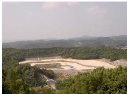
平成19年8月 (造成工事完成時)
