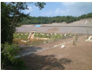
「近自然状態」 周辺環境への調和を考えた 岩組等で整備した調整池
