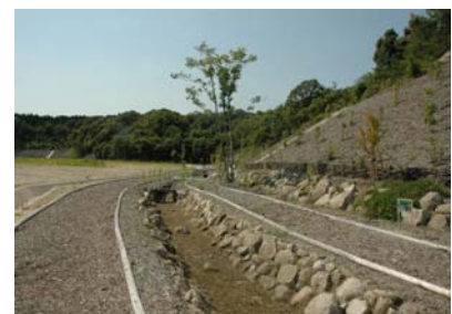
「近自然状態」 せせらぎをイメージして 岩組で整備した外周水路
