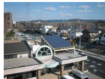
総合検査センター 太陽光発電 ※写真は水質検査棟
