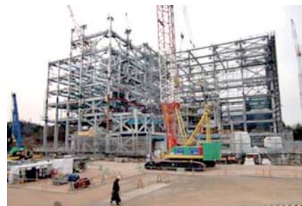
地上工事(工場棟)
