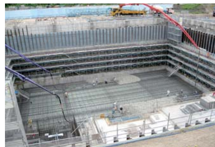
地下工事(ごみピット)
