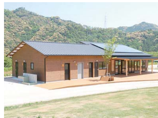
わんParkの管理棟「わんぱくハウス」
