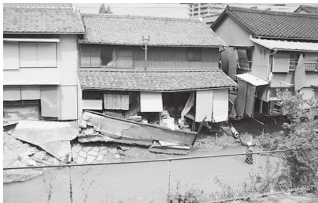
▲平成20年豪雨直後の伊賀川沿いの家屋
