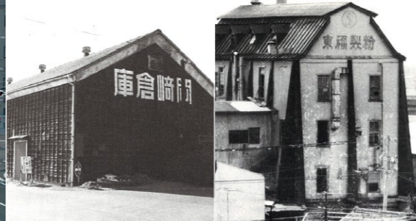
左から、岡崎倉庫、東福製粉、戸崎日清。昭和30年頃まで駅前地区には多くの工場や倉庫があった
