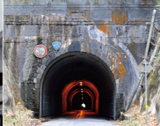
3 本宿と蒲郡を結ぶ全長468mの鉢地坂トンネル
