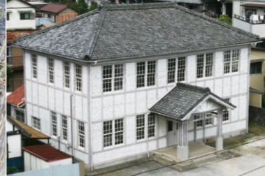
2 旧本宿村役場。平成20年(2008)から公共下水道工事に伴い、解体を始める。近代化歴史遺産として復原予定
