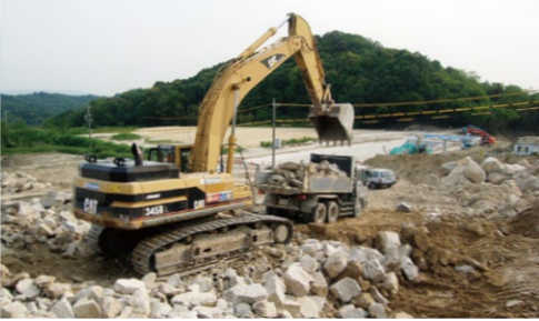
順調に造成工事が進められた「エコロタウンときわ南」
