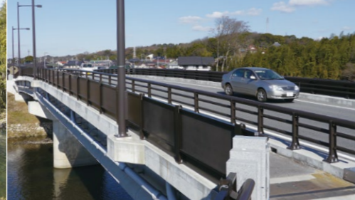
生徒も学生も一般の人も、車を気にせず安全にゆとり通行できるようになった丸岡新橋
