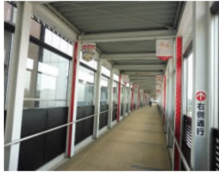
市役所連絡通路
