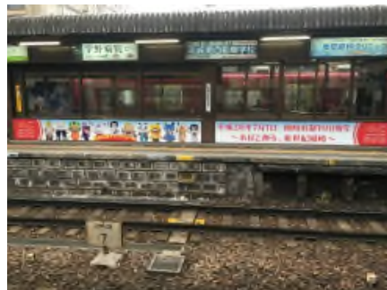
東岡崎駅プラットホーム
