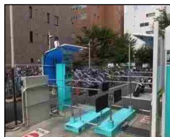
(2) 出入口ゲート
