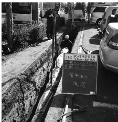
鋳鉄管敷設工事
