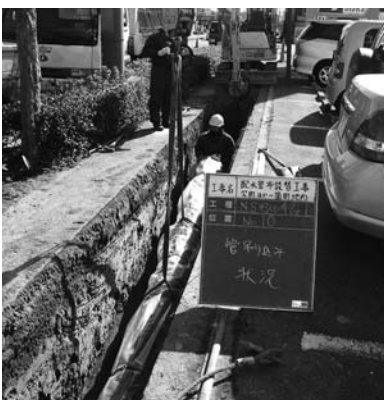
鋳鉄管敷設工事
