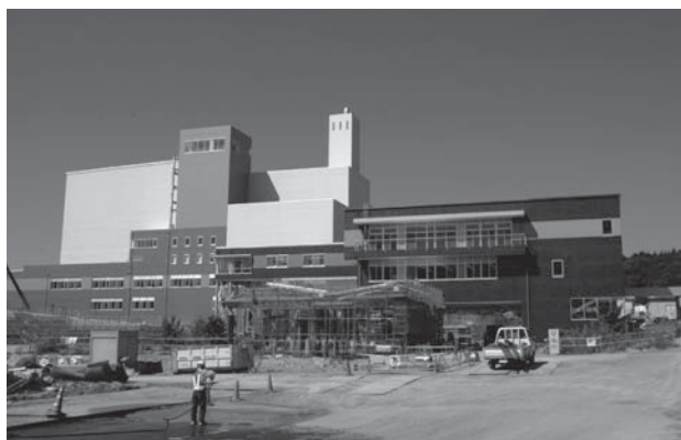
新一般廃棄物中間処理施設
