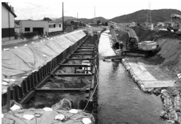
占部川下流の改修状況
