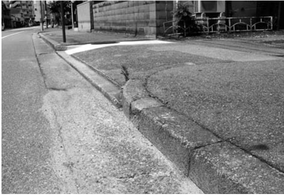
マウントアップ型歩道
