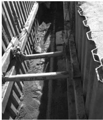
下水道工事現場
