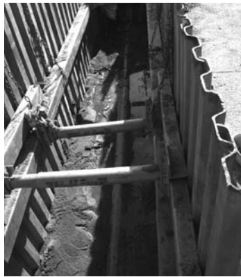
下水道工事現場
