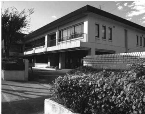
総合検査センター
