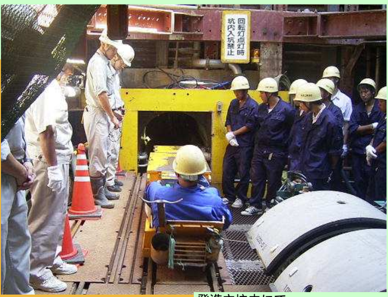
発進立坑内にて バッテリーカーで管内に入る作業 セグメントを模擬的に組み付ける作業 などの説明
