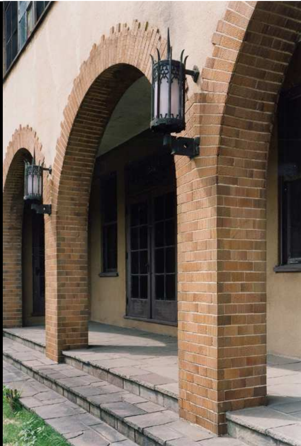
三連アーチの外観
